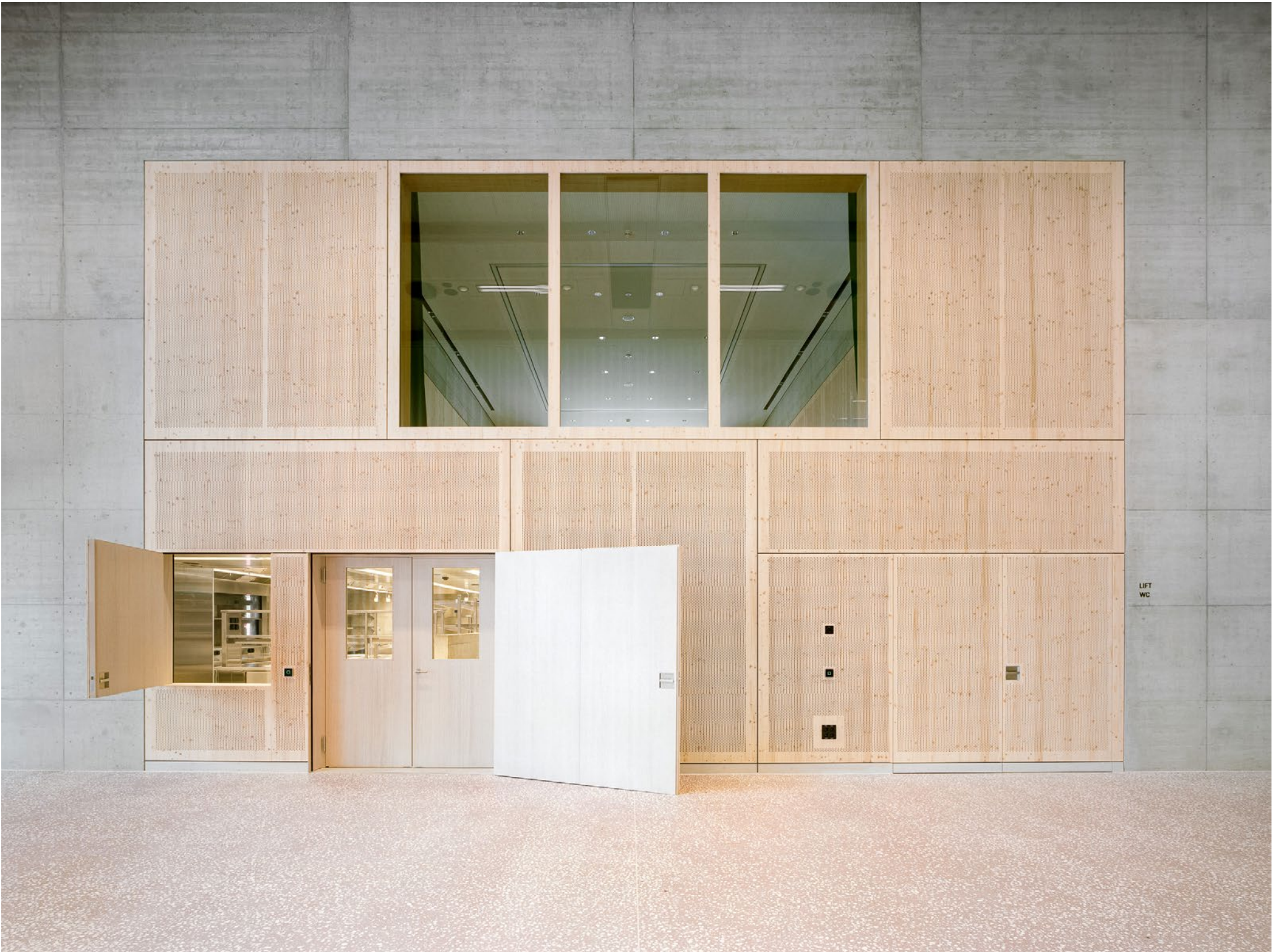
Mehrzweckhalle Dorfzentrum Untersiggenthal
