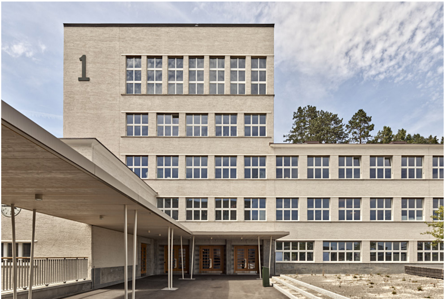
Schulanlage Burghalde, Instandsetzung Stadt Baden
